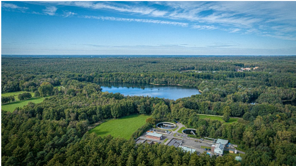
Figuur 1 Luchtopname van zuiveringsinstallatie Overhelfeld in het Swalmdal met op de achtergrond de Damen See
