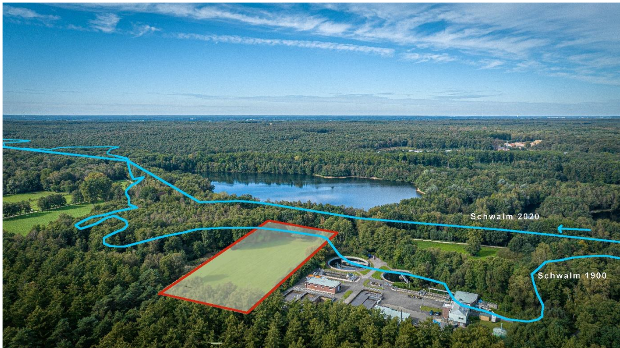
Figuur 2 Luchtopname van zuiveringsinstallatie Overhetfeld met op de achtergrond de Damen See met ingetekende de Swalm anno 2020, de oorspronkelijke loop in 1900 en de ligging geplande uitbreiding (rood-geel) (Bron: foto en bewerking Groen Grensland)
